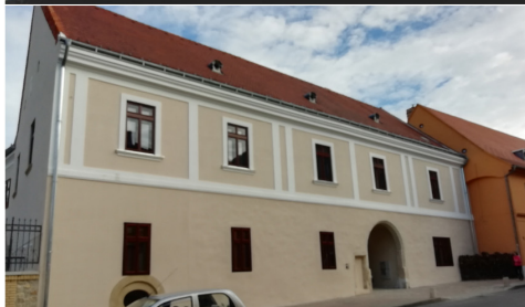
Az Egyházmegyei Könyvtár épülete: felújítás előtt és után
