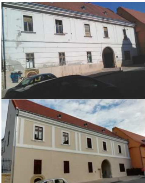
Az Egyházmegyei Könyvtár épülete: felújítás előtt és után
